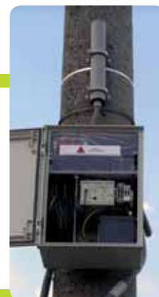
Indikátor zemních spojení s měřením U a napájením pomocí kapacitních děličů
