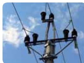
Indikátor zemních spojení s měřením U a napájením pomocí kapacitních děličů
